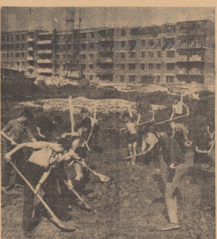
Elevi ai Liceului „Gheorghe Lazăr” la muncă patriotică pe șantierul de locuințe din cartierul Hipodrom
