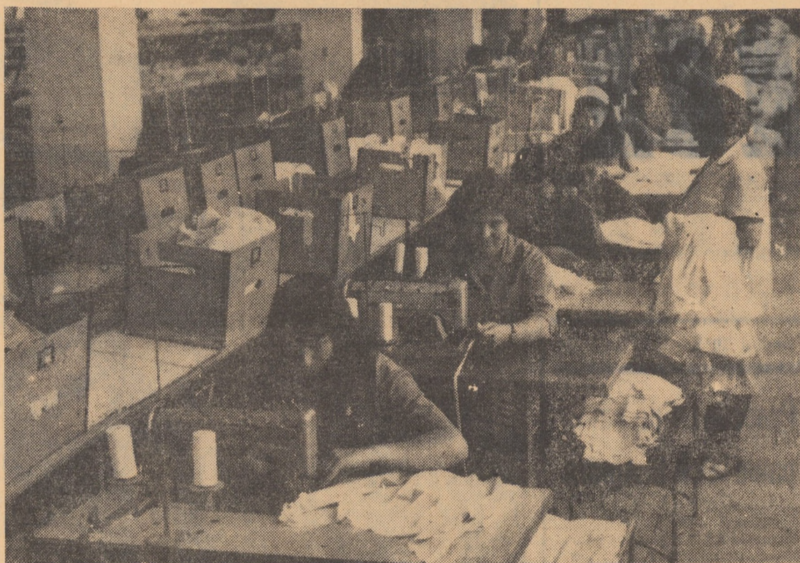
Aspect din secția confecției mătase a fabricii „Drapelul roșu” Sibiu. Locurile de muncă sînt aprovizionate cu ajutorul unei benzi rulante, o formă superioară de organizare a producției și a muncii
