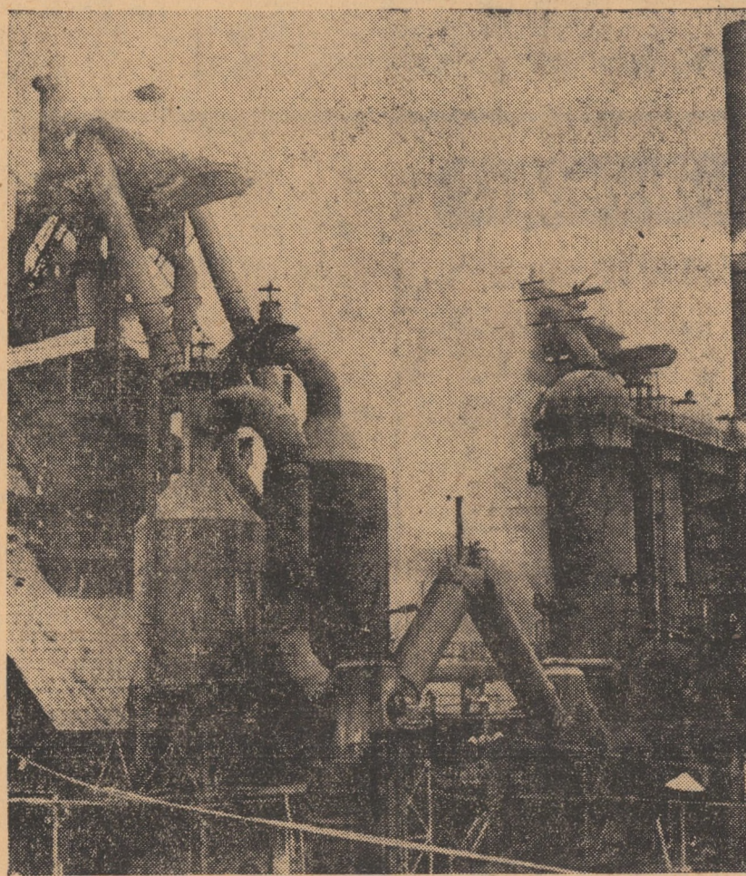
R.P.D. COREEANĂ. Vedere parțială a Combinatului siderurgic Hwanghai
