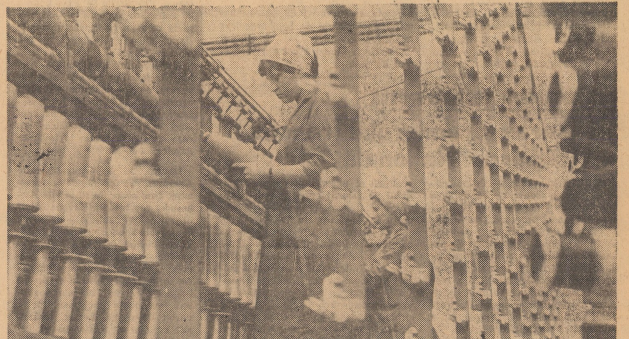
Mașini de răsucit cu mare randament realizează fire necesare producției de covoare plușate
