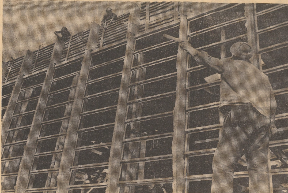
Suprafața totală a noilor construcții industriale, aparținînd uzinei „Automecanica” din Sibiu, ridicate în zona industrială de lângă uzina „Elastic”, se ridică la circa 25.000 m.p. În fotografie: fațada uneia dintre hale, în curs de lucru
