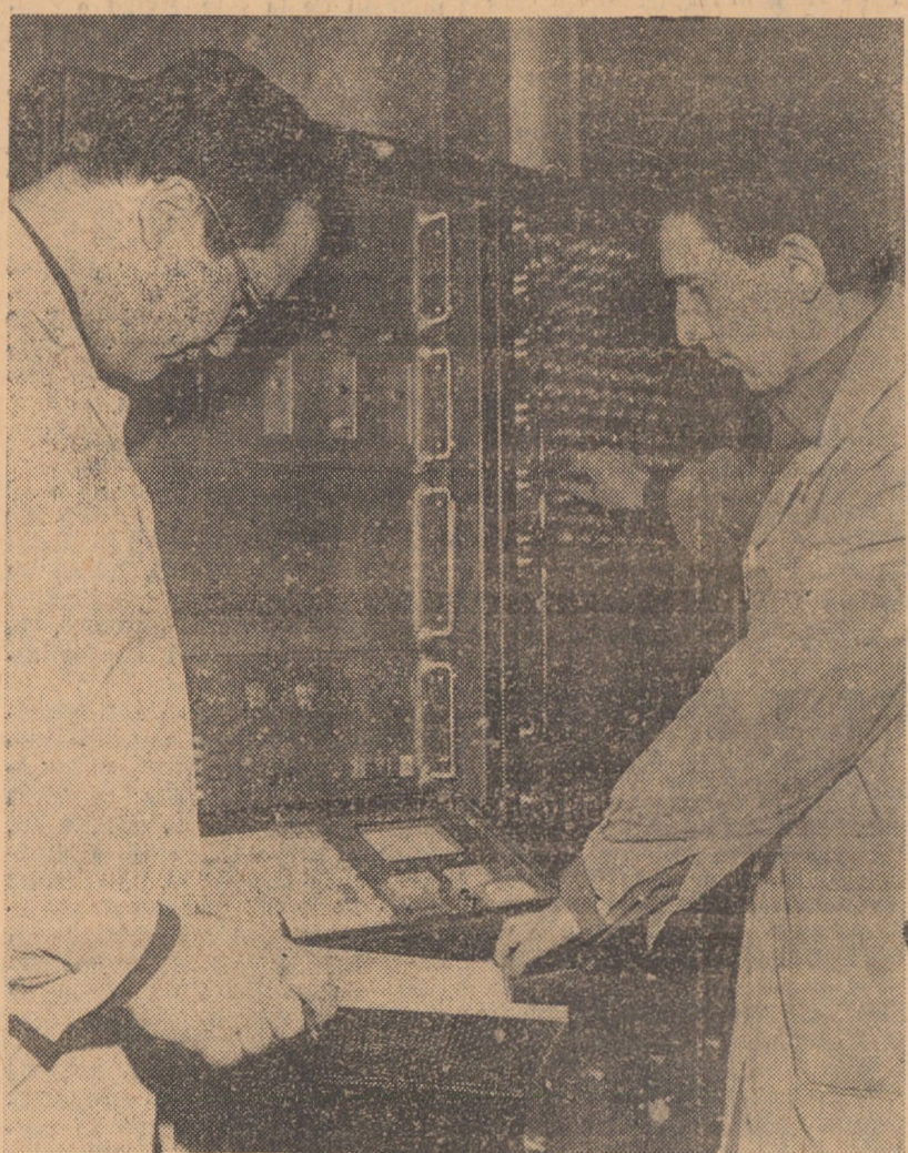
În laboratorul central al Uzinei chimico-metalurgice Copșa Mică, fizicianul Rolf Diezko (stînga) și laborantul Mircea Popescu efectuează analize de aglomerat și zgura pentru noile instalații ale furnalului, cu ajutorul cuantometrului — spectograf cu citire directă, complet automatizat
