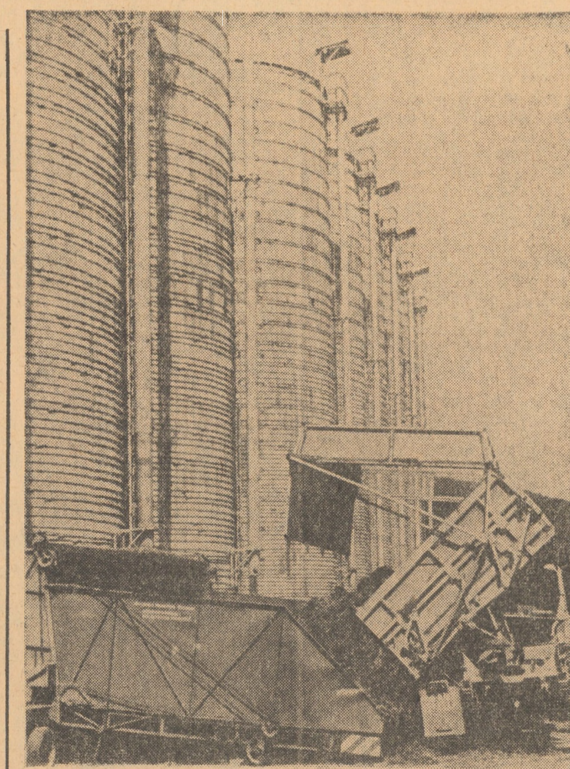
R.D.G. În foto: la ferma Roemhild din regiunea Suhl s-au construit silozuri moderne pentru furaje cu un sistem rapid de descărcare a materialelor și de depozitare a lor
