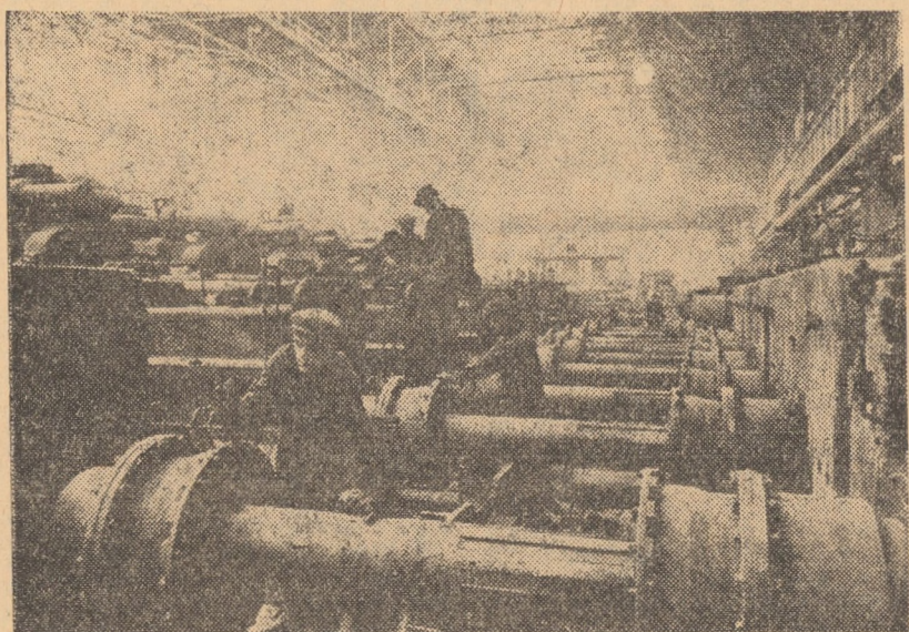
U.R.S.S. Noul laminor „250”. La uzina metalurgică din Cellabinsk se construiește cu mijloace tehnice moderne laminorul de sirmă cu acțiune continuă „250”. Noul tip de laminor este destinat pentru producția de sirmă cu un diametru de 5,6 milimetri. În foto: Montarea noului laminor
