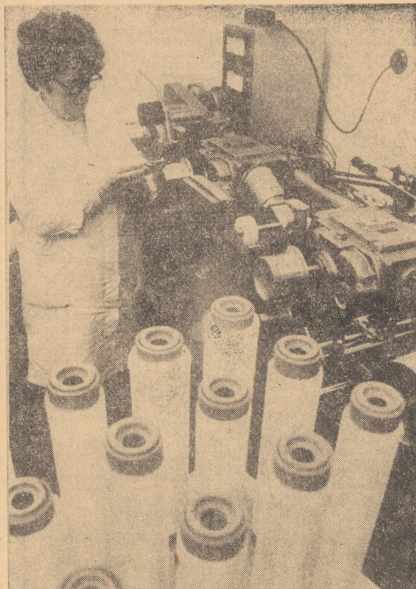
R.D. GERMANIA. Una dintre problemele care se află în curs de cercetare la Institutul pentru chimia polimerilor din cadrul Academiei de Științe din Berlin, este viteza de lungire a fibrelor artificiale, factor determinant în producerea acestor fibre, deoarece le dă anumite caracteristici de structură. În foto: Imagine din laboratorul unde se cercetează această problemă
