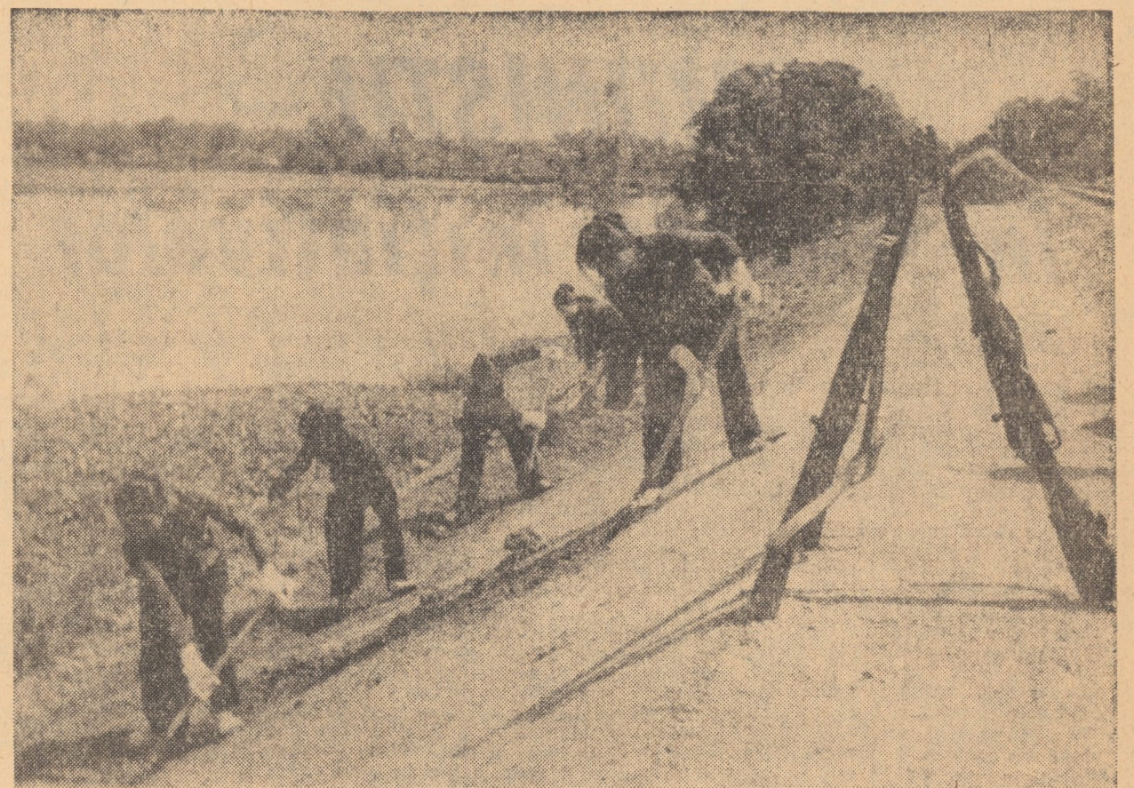
R.D. VIETNAM. Anii îndelungați de război și recente bombardamente americane, au distrus o serie de șosele și poduri în R.D. Vietnam. Echipa de muncitori constructori de poduri și șosele se deplasează continuu în punctele în care prezența lor este necesară. În foto: echipa de femei constructori, nr. 609, de la Departamentul General al Căilor Ferate, lucrînd la repararea unui terasament. Echipa, pentru realizările sale, a fost decorată cu Ordinul Muncii.
