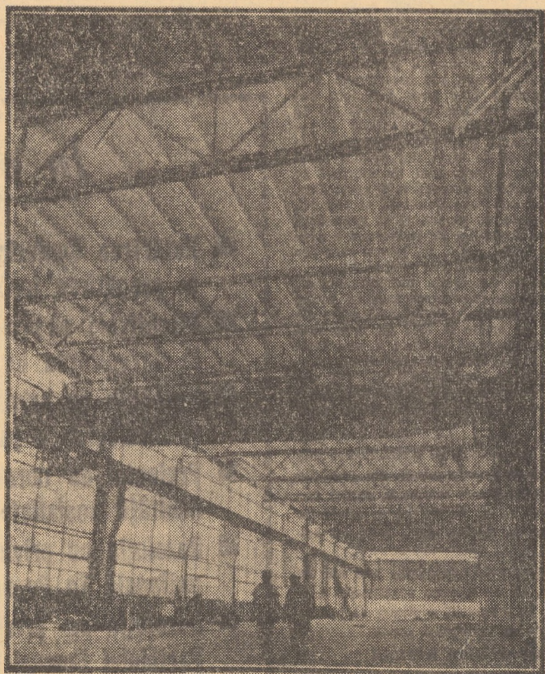
Santierul de construcții Sibiu, lotul „Independența” II. Sala de utilaj complex. Foto: FRED NUSS
