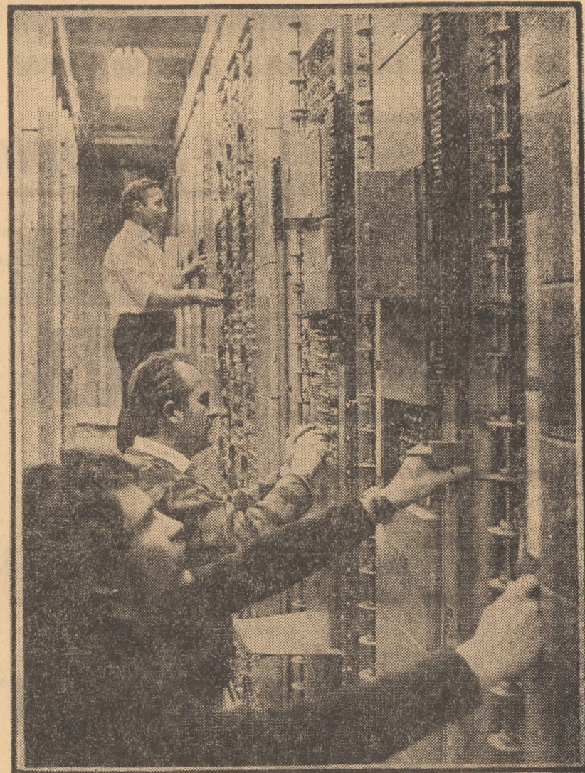
Imagine din interiorul centralei telefonice automate din Medias
