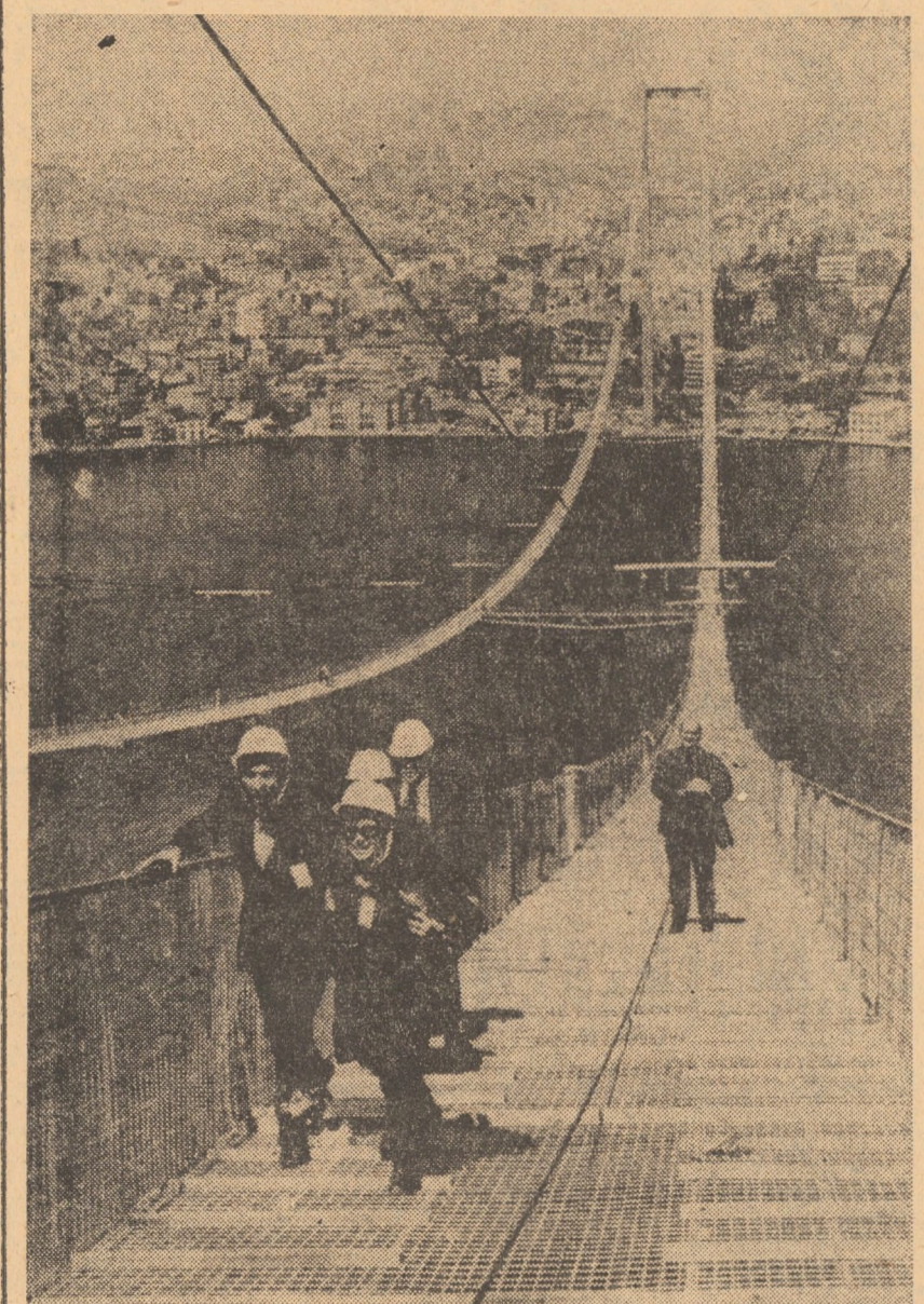
TURCIA. A fost realizat proiectul unui pod suspendat, care să unească continentul european și cel asiatic prin strîmtorarea Bosfor. Proiectul se află în prezent în ultima fază a construcției iar terminarea lui este preconizată pentru anul 1973. Podul, care are o lungime de 1,6 km, este susținut de două turnuri de 165 metri fiecare, înălțate de o parte și de alta a strîmtorii.
