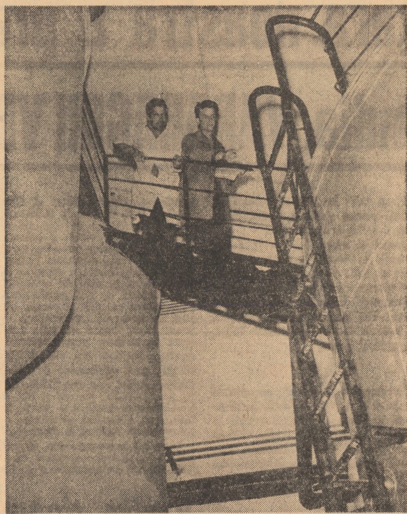
Imagine din sala cazanelor de zaharificare și filtrare a mustului de bere de la Fabrica de bere Sibiu, secția Sadu. — Aici se pot efectua 4 fierberi a 210 hectolitri bere brută în 24 ore
