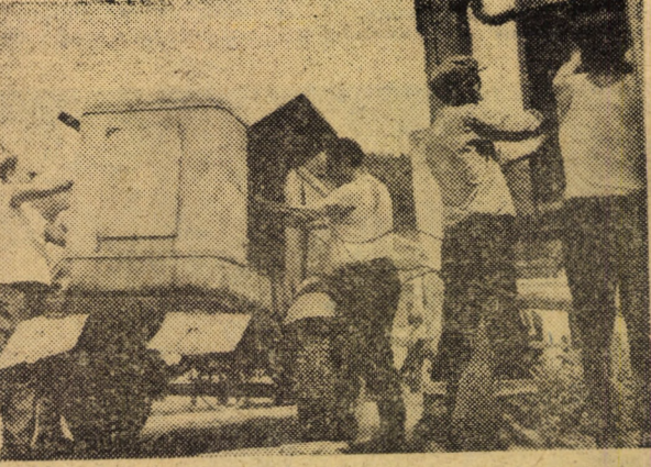
Montarea unui agregat electric la stația de transformare din Șaroșul pe Tîrnava
