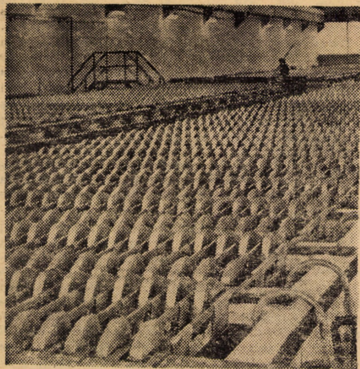
I.M.M.N. Copșa Mică. Hala de electroliză
