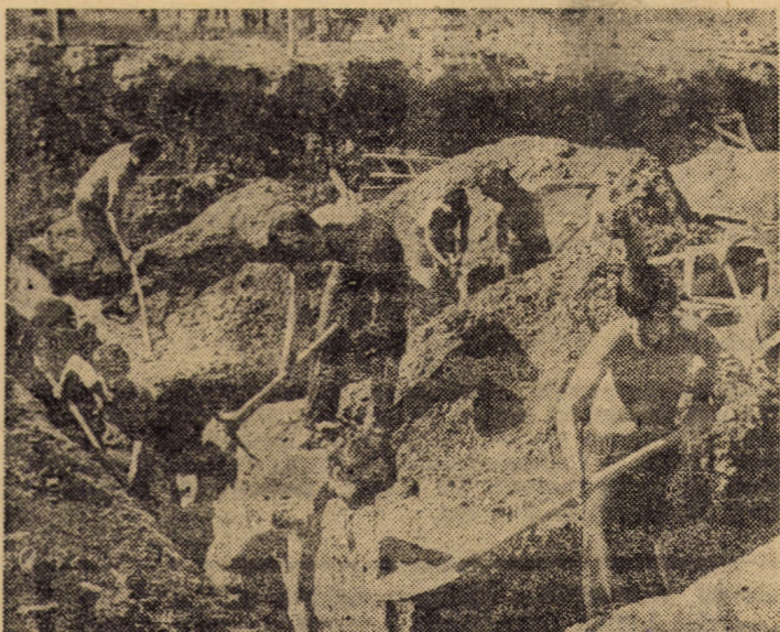
Elevi ai Liceului industrial de chimie Carboșin Copșa Mică la muncă patriotică pe șantierul de construcții din str. Moscova din Sibiu
