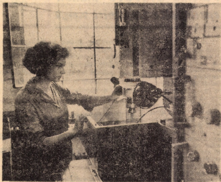
Utecista Maria Stoia din atelierul sculpturii la întreprinderea mecanică Mediaș, deservește o mașină de prelucrat prin electroeroziune, realizînd S.D.V.-uri cu profile de un înalt grad de complexitate
