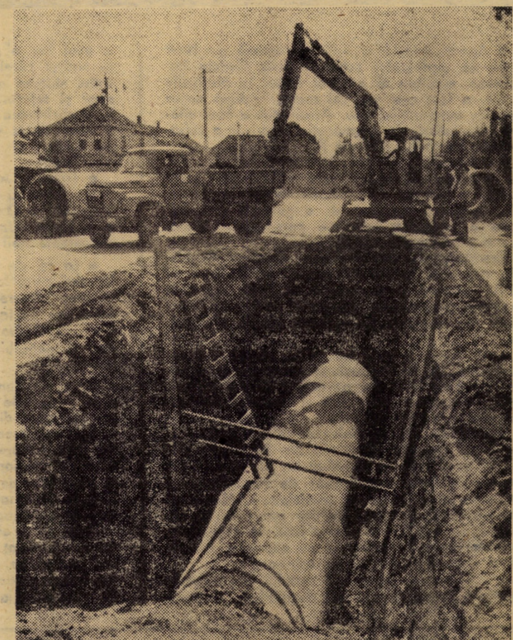
În prezent, printre lucrările edilitare efectuate în municipiul Sibiu figurează și canalul colector U.M. de Ø 1600 mm care va lega cartierul Strand de stația de epurare de la Bungard, lucrare ce va fi finalizată în cursul lunii octombrie a.c. Foto: FRED NUSS
