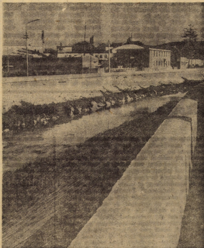
Albia capricioasă a râului Hirtibaci a fost drenată prin mari acțiuni de regularizare a cursului. În imagine lucrări de îndiguire executate în porțiunea ce străbate orașul Agnita
