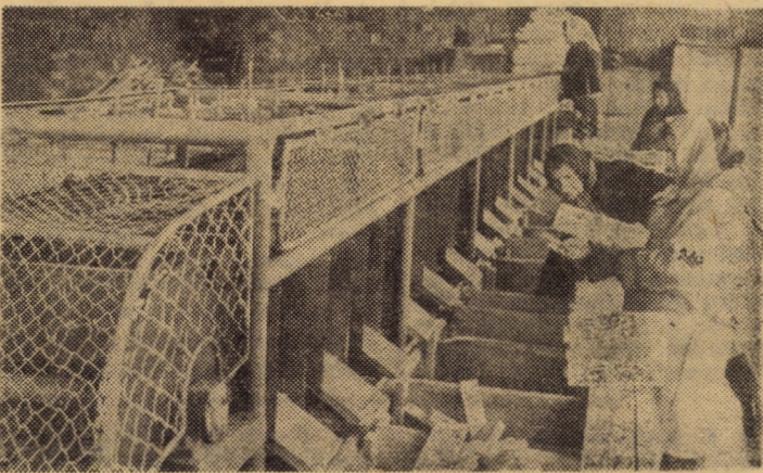
Sortarea frizelor cu ajutorul sortatorului longitudinal la Secția de industrializarea lemnului, Tălmăciu
