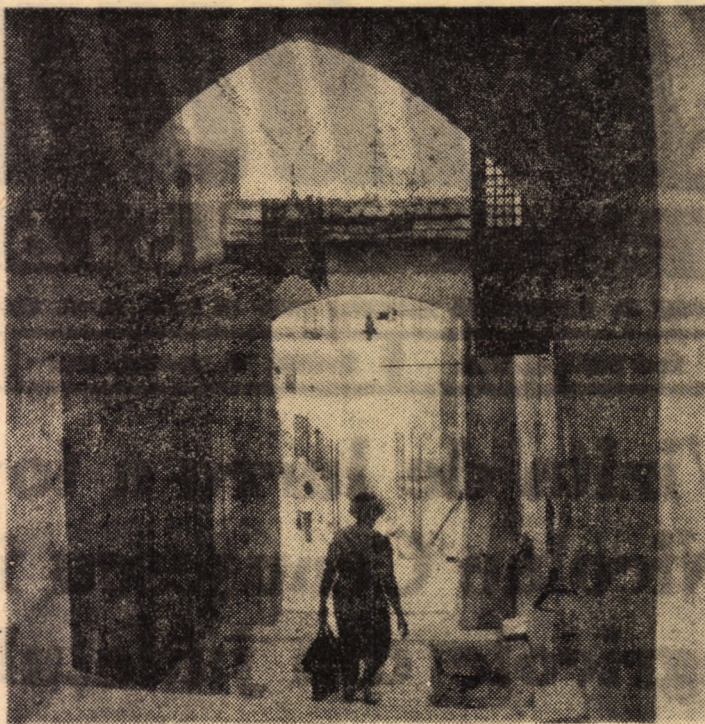
Cale de acces spre „orașul de jos” al Sibiuului: scările aururilor
