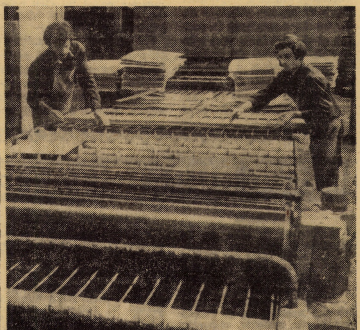
În bună parte, la Fabrica de mobilă din Mediaș, operațiile de finisaj se execută mecanizat cum este de altfel și aplicarea adezivului pe panouri, pregătite astfel pentru faza furniturii
