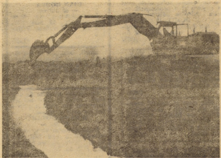
Pentru prevenirea inundării unor întinse suprafețe agricole la Boian, I.E.E.L.F. Sibiu — Sectorul de întreținere și exploatare execută o lucrare de decolmatare și regularizare a Văii Balta, pe o lungime de 4 km Foto: ing. Mircea COLCERIU
