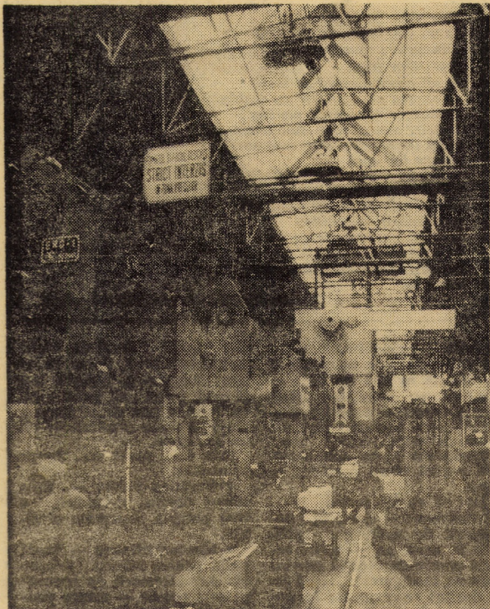
Prin aplicarea unor luminatoare de mari dimensiuni în secția prelucrării mecanice a întreprinderii „Emailul toșu”, Mediaș, consumul de energie electrică a fost redus substanțial. În fotografie: grupul de prese cu transfer. Foto: Fred NUSS
