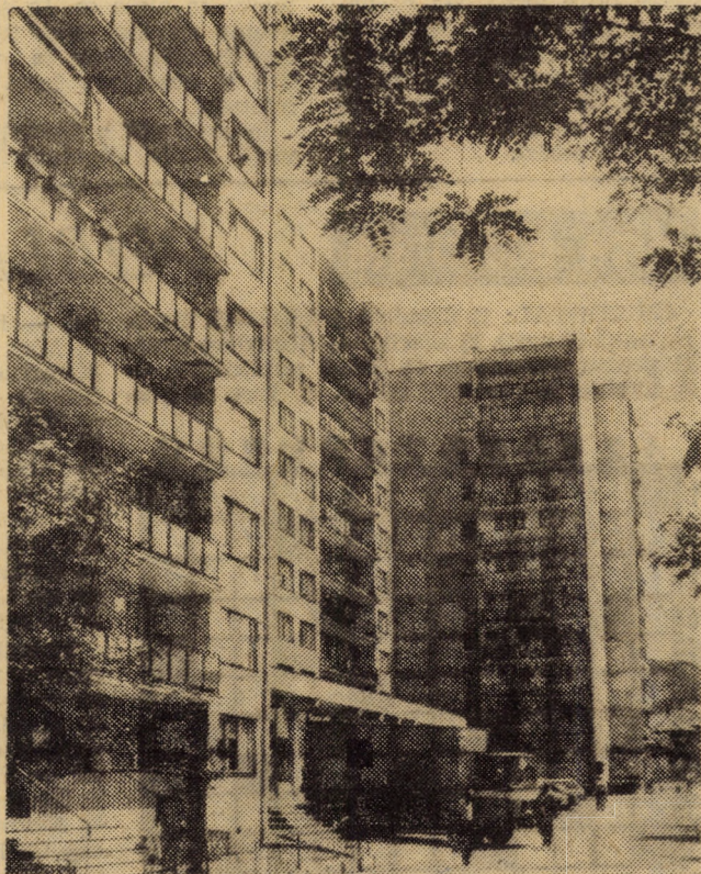
Construcții de locuințe ridicate în anii din urmă în cartierul Gura Cimpului din municipiul Mediaș
