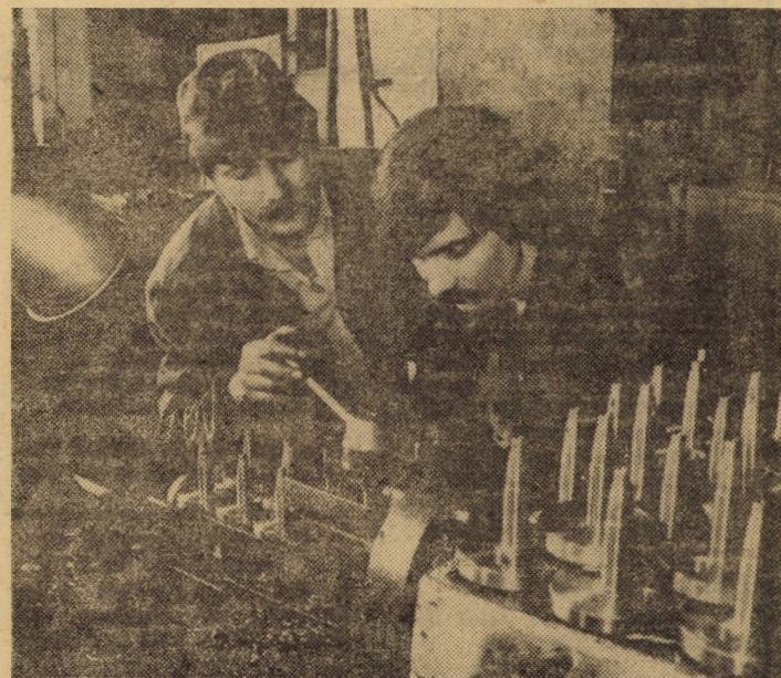
Doi tineri muncitori de la I.U.P.S. Sibiu, din cadrul secției mecanică fină — Ioan Cosma și Werner Gräff — executînd piese de mare precizie (ambielaj pentru motoferăstrăul „Retezat”)
