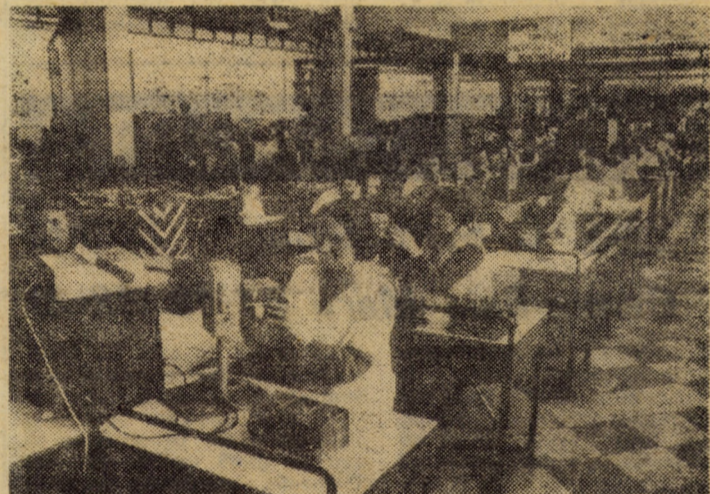
Întreprinderea de relee Mediaș: aspecte de la linia de montaj
