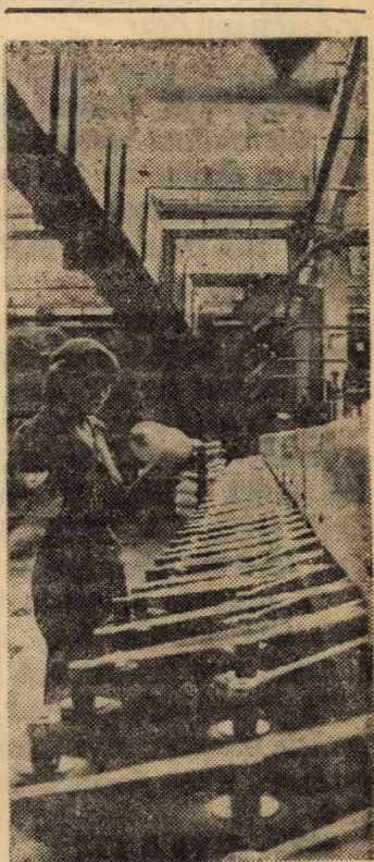
Întreprinderea „Tirnavă” Mediaș. Aspect din noua secție filatură
