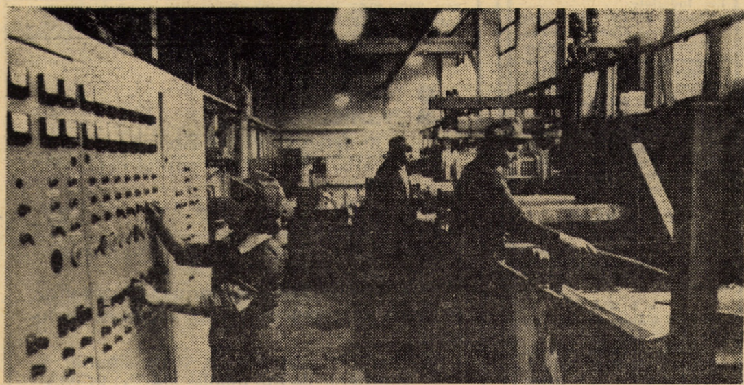
Vă redăm o imagine de ansamblu a instalației semiautomate pentru acoperiri galvanice de la „FLARO” Sibiu. Dată în funcțiune anul trecut, moderna instalație e folosită la galvanizarea diferitelor produse de larg consum, realizate în prezent de această unitate. Foto: Fred NUSS
