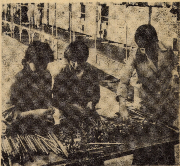
Întreprinderea de piese auto Sibiu. Un aspect din secția de fabricație a amortizoarelor telescopice, unde toate reperiile componente sînt trecute prin mai multe operațiuni de prelucrare, cromare, tratamente etc., în vederea asigurării calității prescrise în documentațiile tehnice. Foto: Fred NUSS
