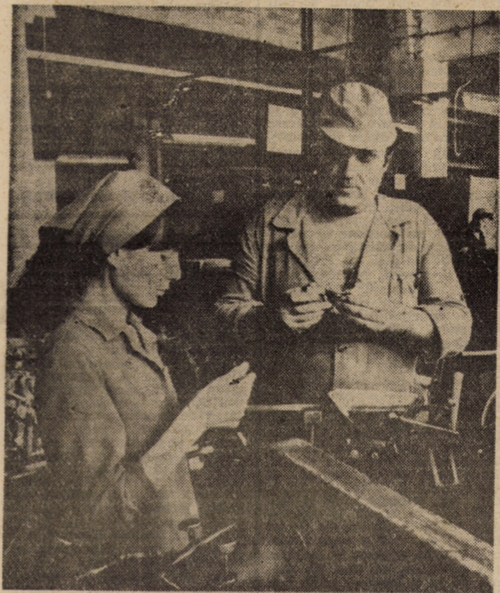
Întreprinderea „Flamura Roșie” Sibiu, secția metal II. Verificarea cotelor de prelucrare a acelor de cusut pentru mașini, efectuată de reglorul Gheorghe Daju la grupul mașinilor de frezat canal, deservit de muncitoarea Viorica Maria
