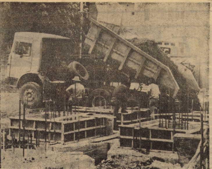
La viitorul Centru de medicină preventivă Sibiu (ce se construiește lângă Spitalul județean Sibiu) constructorii de la „CONSIB” S.A. (fostă A.C. IND. Sibiu) lucrează intens la turnarea fundațiilor și armarea stîlpilor pentru demisol Foto: Fred NUSS
