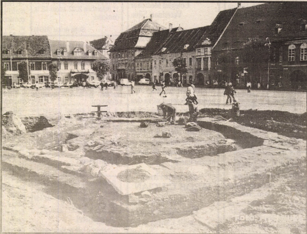
Încât acest șantier să fie și un obiectiv turistic" spune arhitectul șef al municipiului, Szabolcs Guttman. Adrian POPESCU
