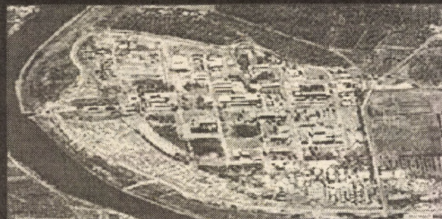
Compania Ibn Sina din Tarmiyah. Unul din centrele despre care dosarul afirmă că este de "folosință duală, putând fi utilizat la obținerea unor agenți chimici și a unor produse folosite la fabricarea de arme chimice".
