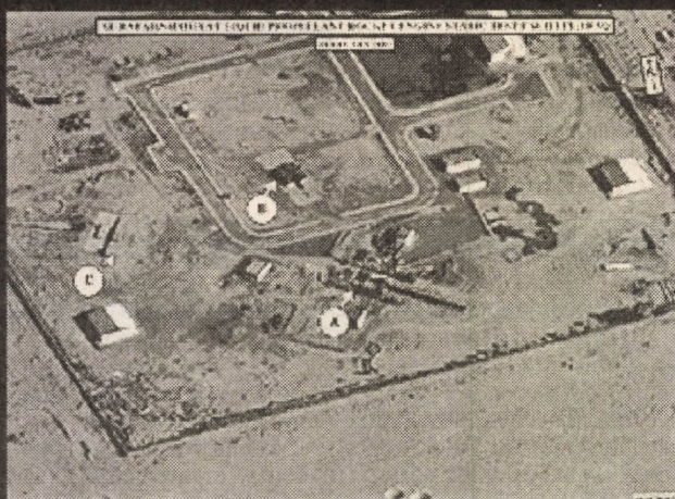
Litera (A) indică bancul de testare static al motoarelor cu combustibil lichid, Al-Rafah-Shahiyat, despre care raportul afirmă că este mai voluminos decât cel pentru rachetele al-Samoud(B) și cel folosit anterior la testarea motoarelor rachetelor de tipul SCUD(C), demontat sub supravegherea inspectorilor de arme. "Noul banc de testare va fi capabil de verificarea motoarelor rachetelor cu rază medie de acțiune, de peste 1000 de kilometri, care nu sunt permise de Rezoluția numărul 687 a Consiliului de Securitate".
