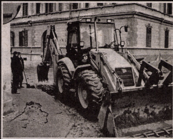
Printre străzile "răscolite" în prezent pentru a fi modernizate se numără și str. Odobescu din Sibiu. După cum ne arată și imaginile, aici se intervine cu utilaje grele, probabil pentru a grăbi lucrările, căci iarna-i pe aproape. Fred NUSS
