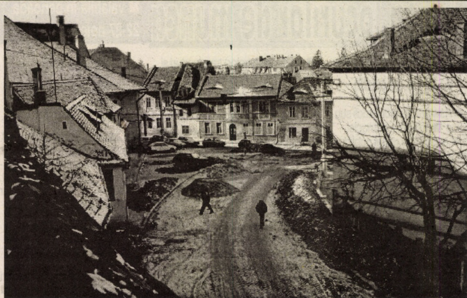
I-a venit rândul și străzii Al. Odobescu, din Sibiu, să fie refăcută și modernizată. Deocamdată au fost scoase pietrele cubice, iar restul lucrărilor sunt în curs de pregătire. Încă o stradă care va avea, așadar, pavaj "clasic".
