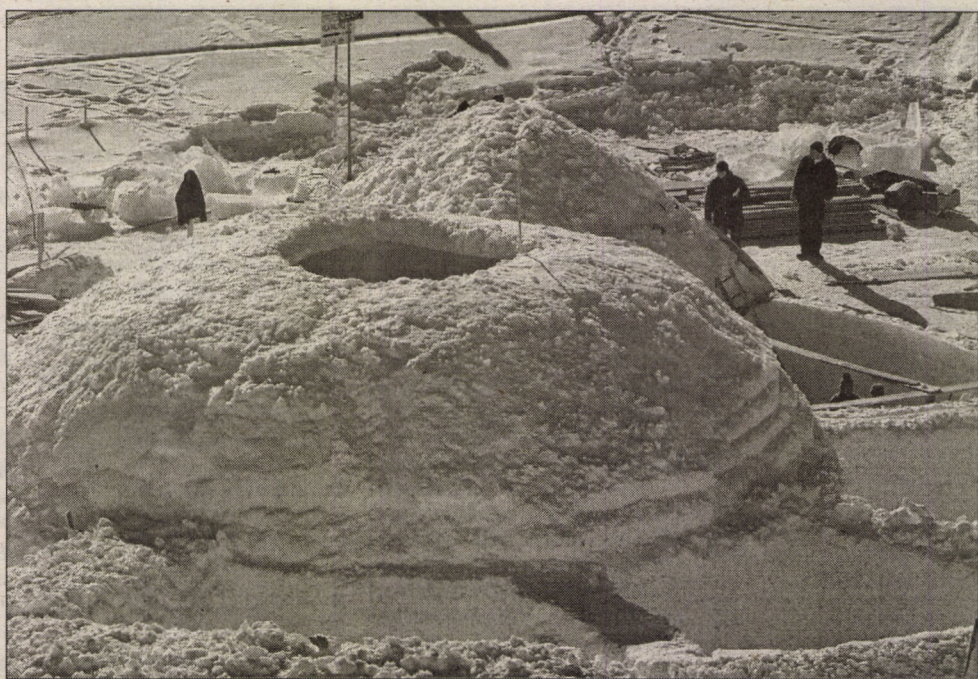
Hotelul de gheață, în timpul construcției
