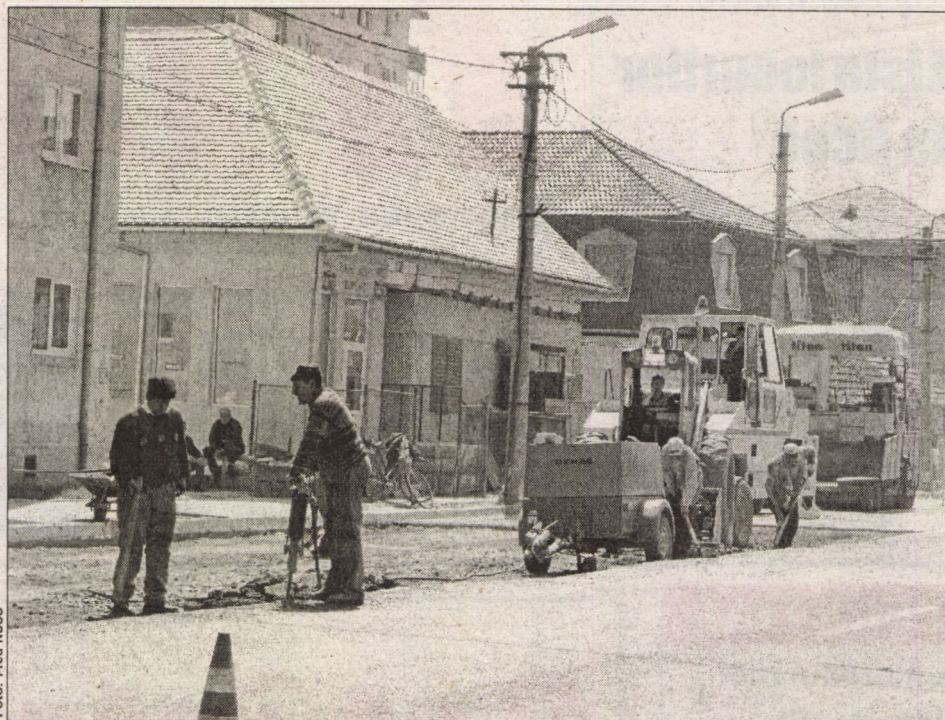
SA au intervenit pentru executarea în formă finită a acestor lucrări de reparații a străzii Semaforului.
