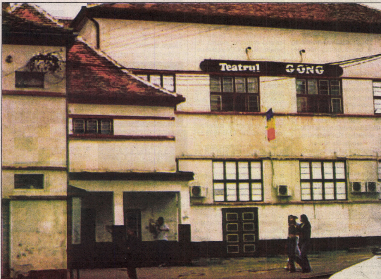
Teatrul Gong înainte de începerea lucrărilor
