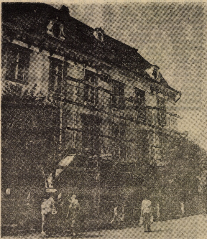
La Muzeul Brukenthal se fac pregătiri atât în interior cit și în exterior pentru primirea vizitatorilor. Foto: I. PREDA
