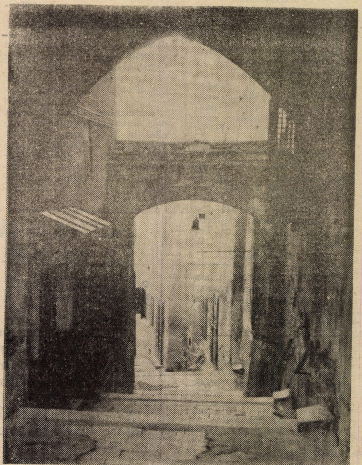
Sibiul istoric azi-mîine nu mai are cum depune mărturie despre trecutul său. Se ruinează. (În imagine: Pasajul scării)
