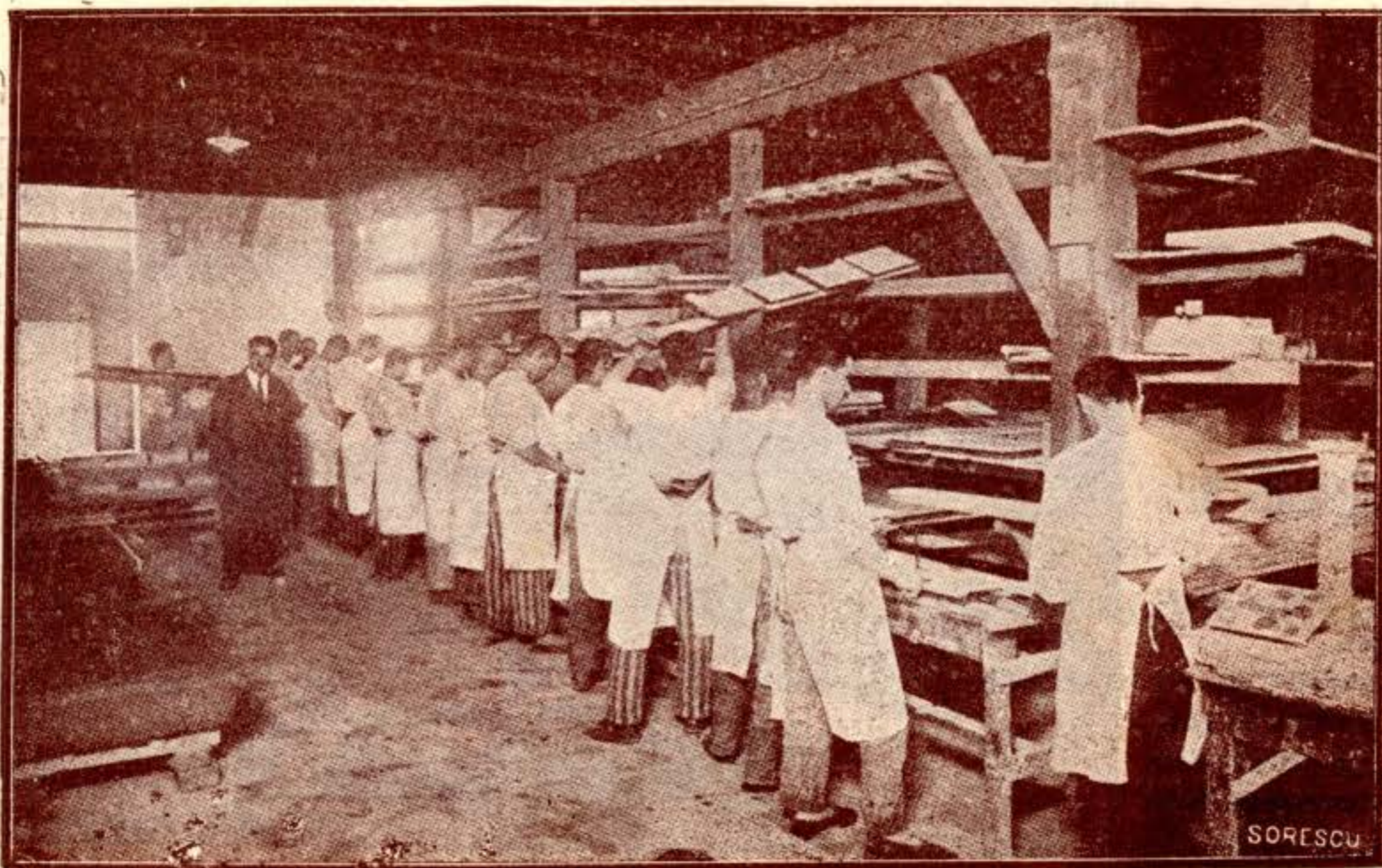
Uscătorie plăcilor de faianță pentru sobe de teracotă din atelierele Penit. Văcărești
