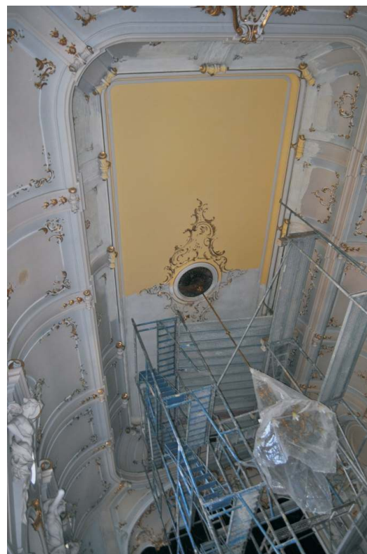
Lucrări de reabilitare Corp A (2010-2011)
