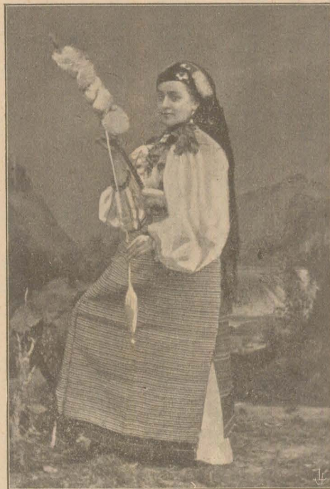
Tórce, lele, tórce, tórce Pân' bădița s'a întórce.
