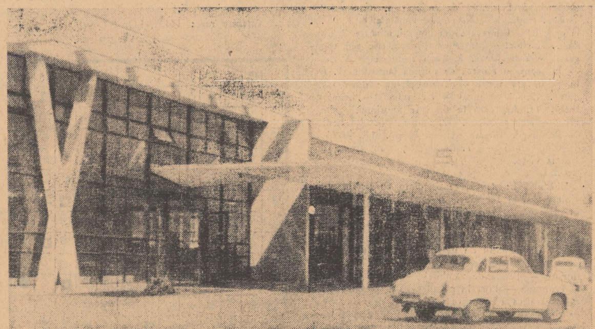
Stația „Autoservice” — Șoseaua Alba Iulia a cooperativei „Tehnică Nouă” din Sibiu
