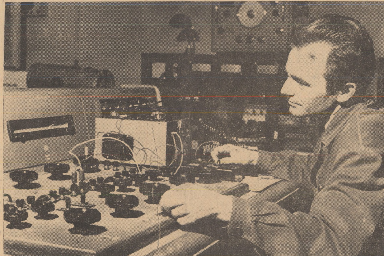
De curând, la I.R.M.E., subunitatea Sibiu, a fost instalată o masă compensatoare de curent continuu, necesară verificării și etalonării aparatelor de măsură de mare precizie, folosite în laboratoarele de reparat instrumente de măsură și control. În fotografie: Erhard Schuster, reparator de aparate, lucrând la noua instalație. Foto: FRED NUSS
