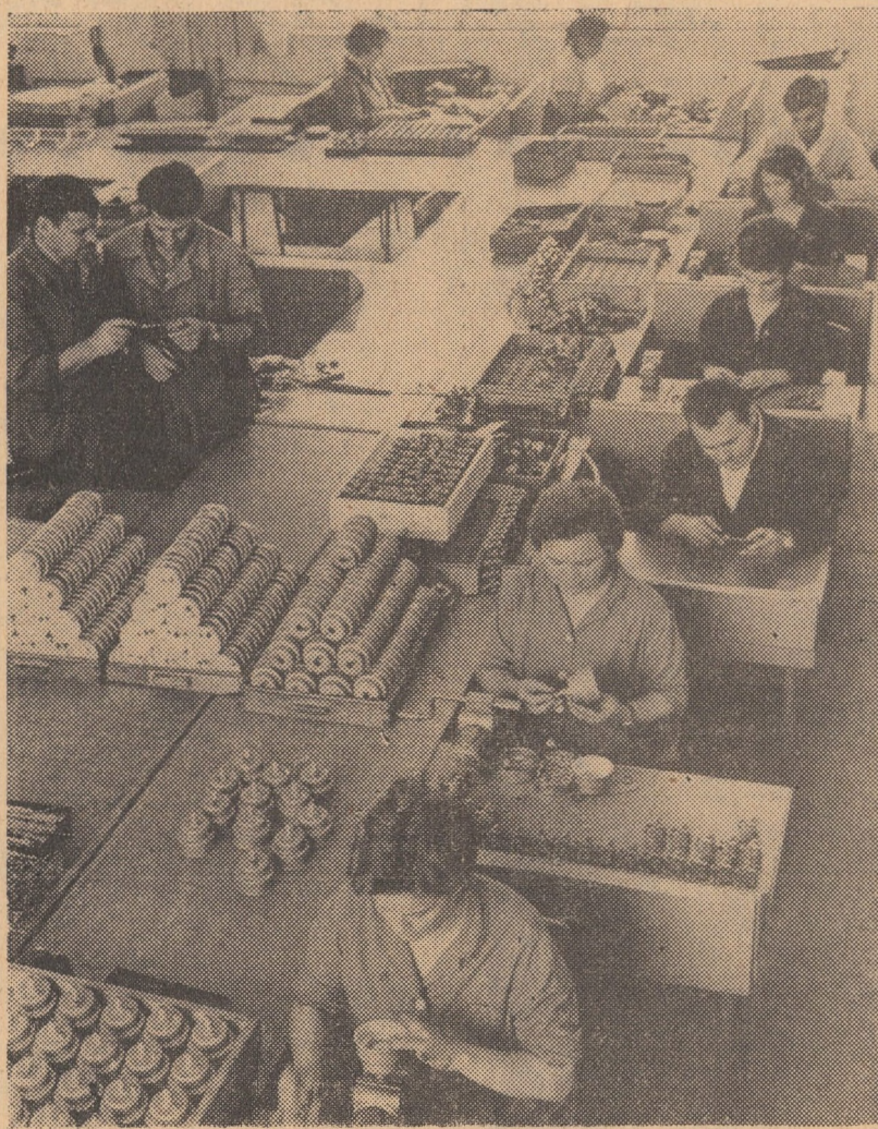
Banda de montaj final al vitezeometrelor și al contoarelor de la uzina „Balanta” din Sibiu.
