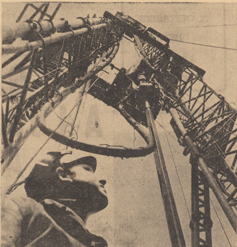
Vedere interioară a unui turn de foraj 4LD la 3.200 m din dotația Întreprinderii de foraj Gaz metan Mediaș
