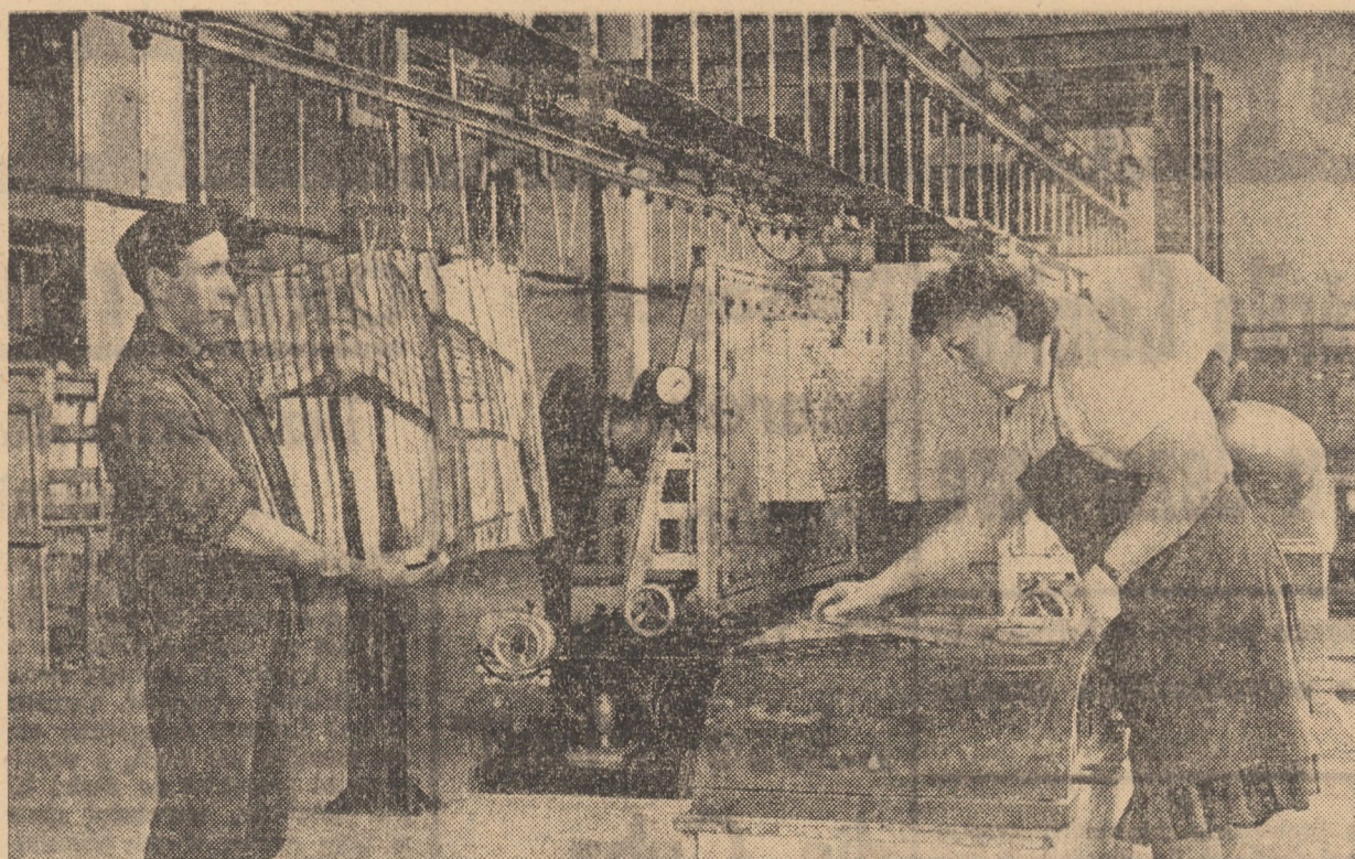
Fabrica de geamuri, Mediaș. Linia de securizare a geamurilor curbate pentru parbrize la autocamioane, autoturisme, tractoare, locomotive electrice etc.
